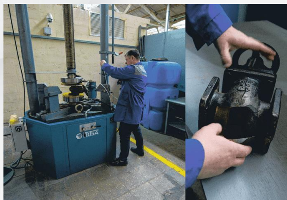
Стенд для гидравлического и пневматического испытания трубопроводов и запорной арматуры, Элементы трубопровода и клапаны.
